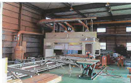
CLTや大断面材に対応する全自動6軸加工機(ユニチーム)
