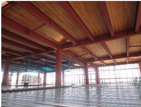
5F天井部分 CLTを現しで使用
