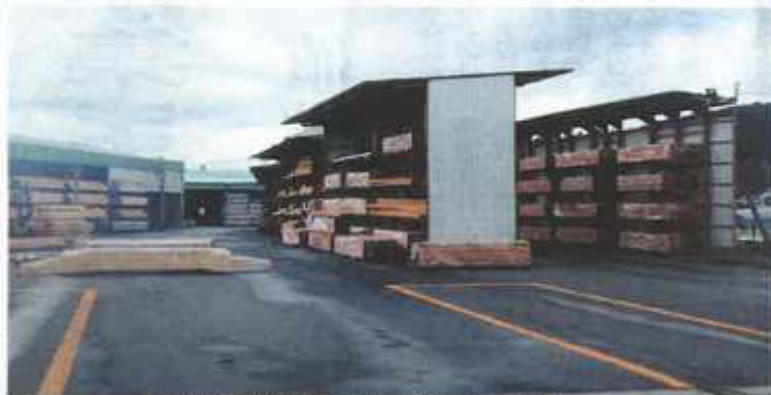
スカイ豊岡本社工場の製品ストックヤード
